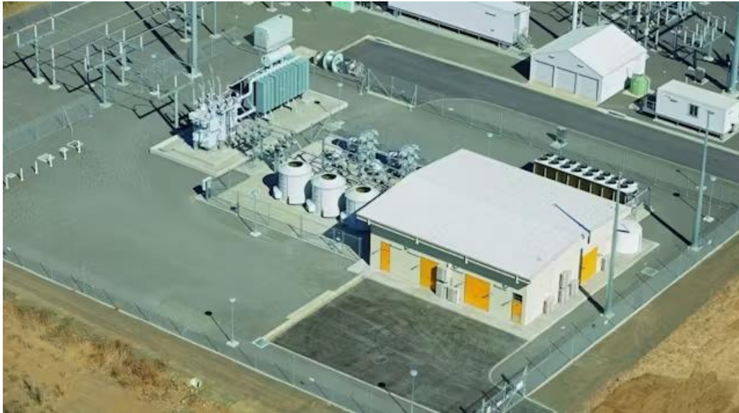
Imagen 2. Configuración de un STATCOM en redes de transmisión
