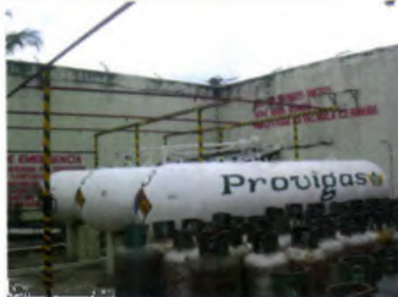
EL GLP DE LOS CILINDROS DE TRANSPORTE TAMBIÉN PUEDE SER TRANSFERIDO A TANQUES DE ALMACENAMIENTO
