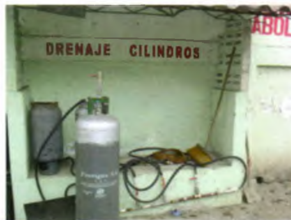
AUNQUE LOS CUNCHOS SON MÍNIMOS LA PLANTA CUENTA CON UN ÁREA PARA EL DRENAJE DE CILINDROS
