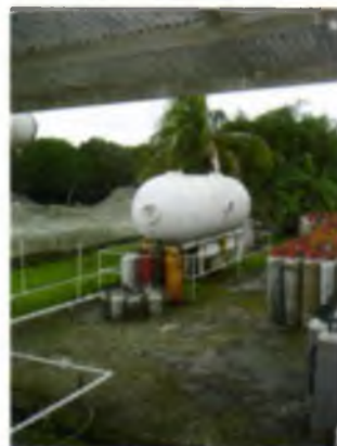
EL GLP DE LOS CILINDROS DE TRANSPORTE TAMBIÉN PUEDE SER TRANSFERIDO A TANQUES DE ALMACENAMIENTO
