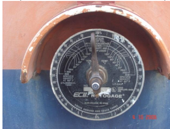
Figura 33. Vista exterior de un dispositivo de medición de nivel de llenado tipo rotogage [90].
