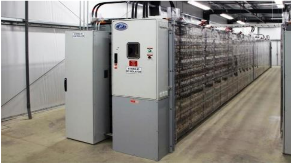
Figura 20. Proyecto con baterías de plomo-acido en Lyon Station, Pennsylvania para la regulación de la frecuencia.
