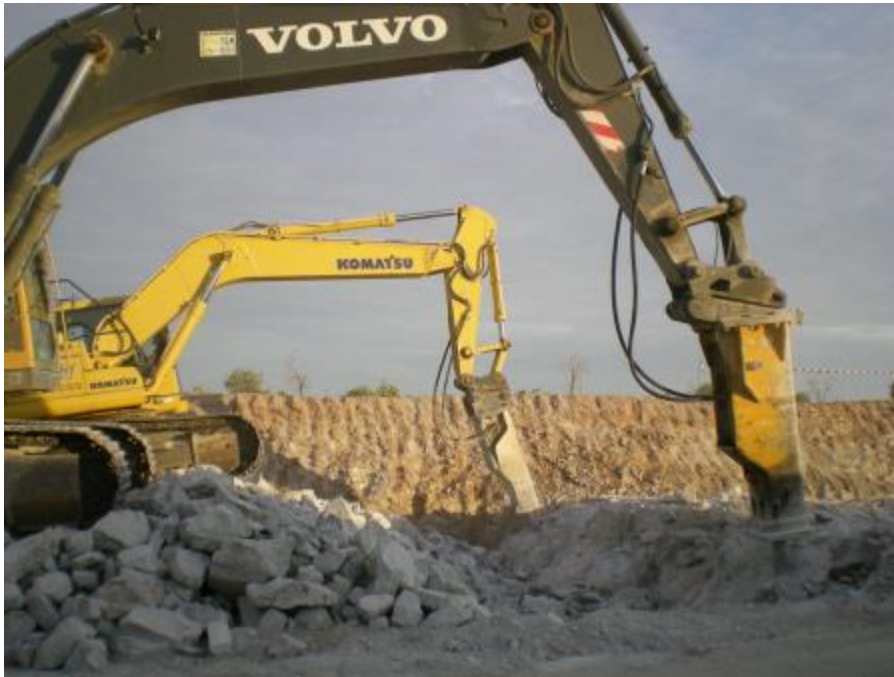
Foto N°6 Construcción en terreno rocoso
