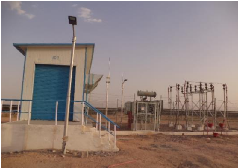
Foto N°8. Edificio de inversor
