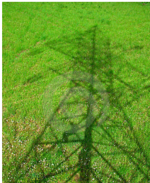
Foto N°5. Sombras producidas por línea AT
