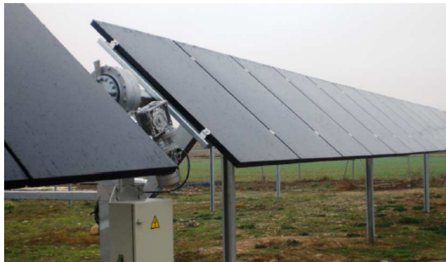
Figura 10. Foto de una instalación usando estructura con seguimiento en 1 eje
