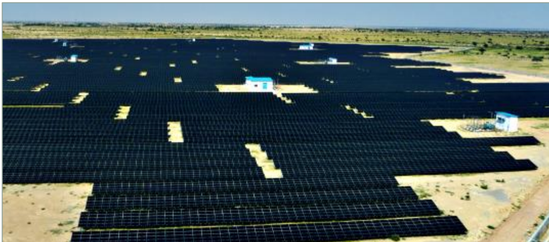
Foto N°7. Distribución de edificios de inversores
