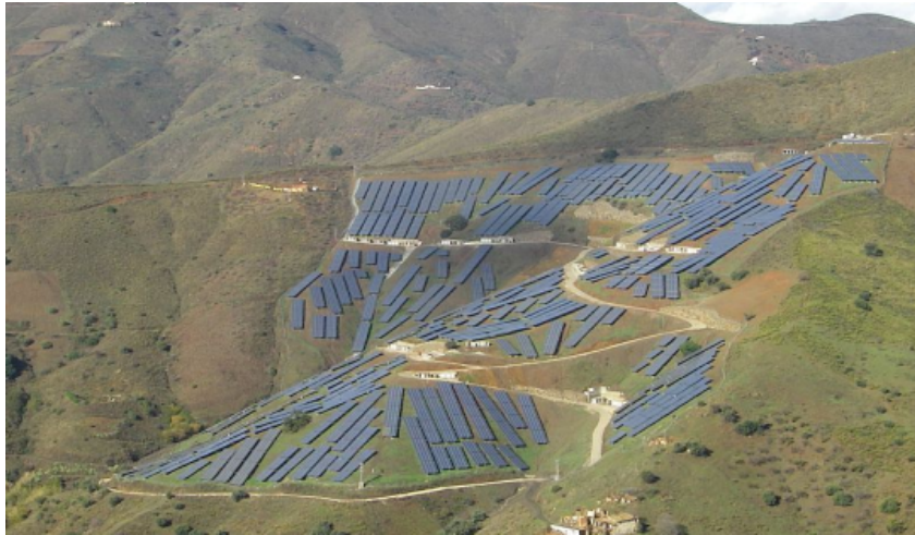
Foto N°4. Planta construida en ladera de montaña
