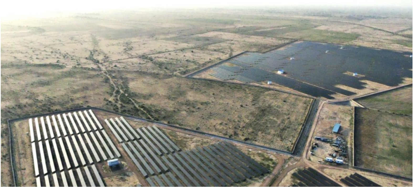
Planta de potencia 15+5 MW de FONROCHE
