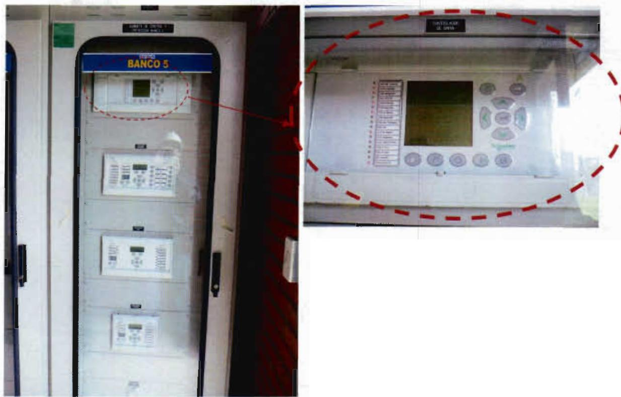
En la Resolución CREG 097 de 2008 bajo la denominación de Unidad de Adquisición de Datos (N4EQ1) se remunera el conjunto de equipos requeridos para cumplir con las funciones de controlar varias bahías al tiempo en una misma subestación.
