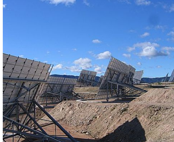
Figura 12. Imágenes correspondientes al fabricante TITAN TRACKER para un seguidor de hasta 30kWp
