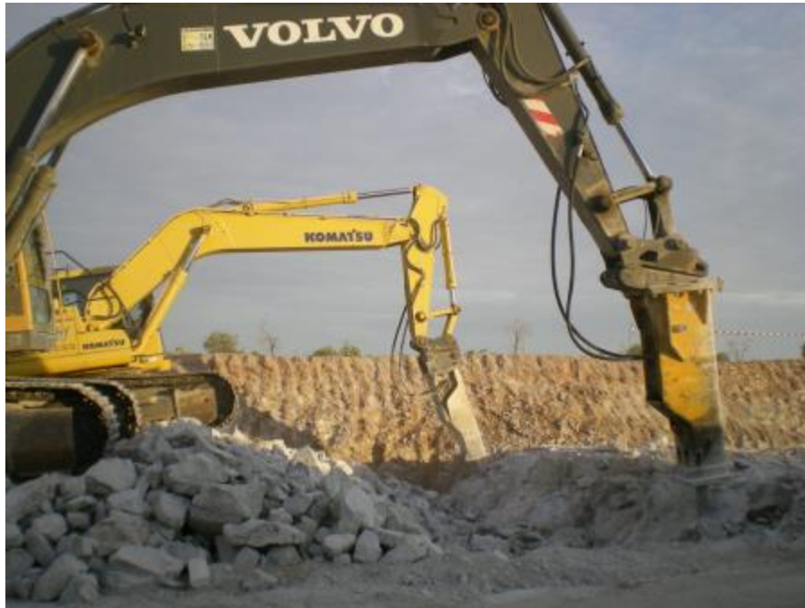
Foto N°6 Construcción en terreno rocoso
