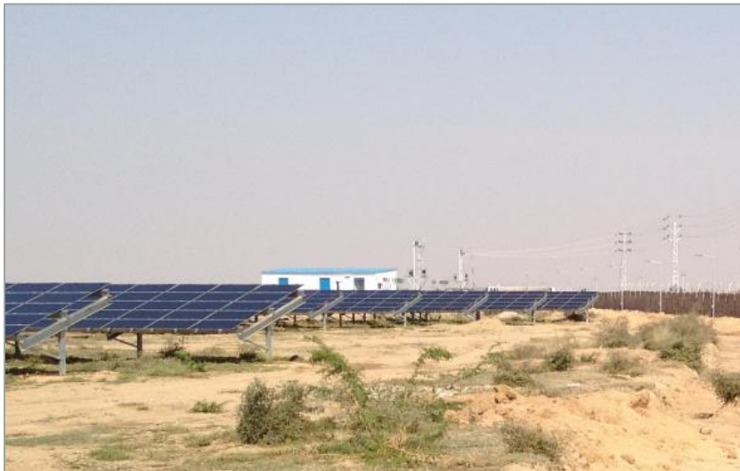
Foto N°9. Oficina y subestación
