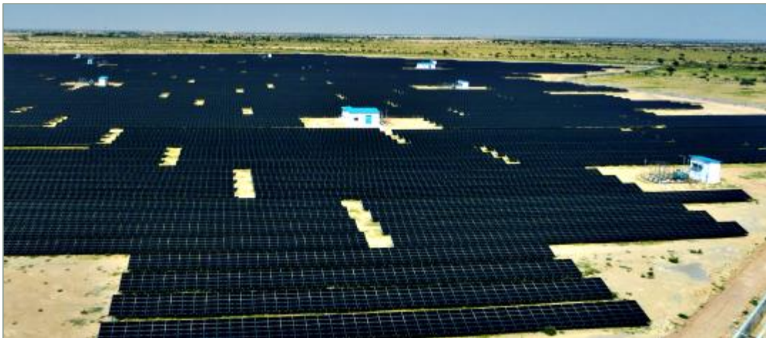
Foto N°7. Distribución de edificios de inversores
