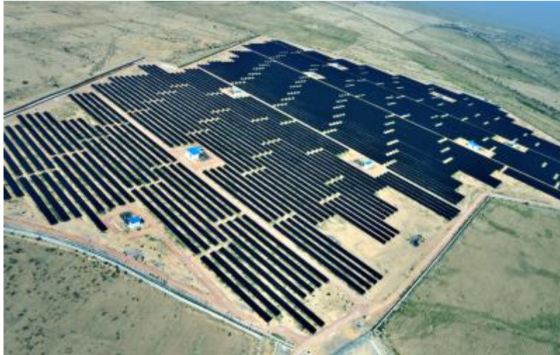
Foto N°2. Vista de pájaro de la misma planta
