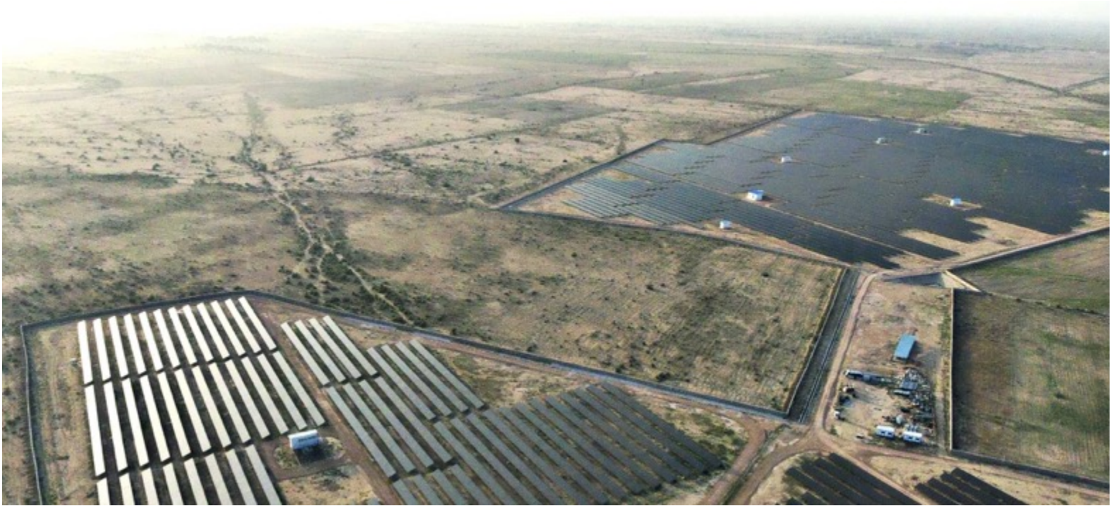
Planta de potencia 15+5 MW de FONROCHE
